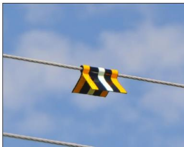
Фиг. 1.11-2 Примерни съоръжения за предпазване на птиците от сблъсък с електропровода
