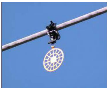
Фиг. 1.11-2 Примерни съоръжения за предпазване на птиците от сблъсък с електропровода
